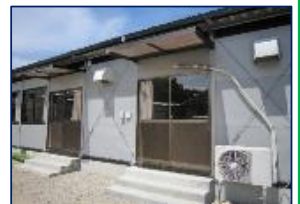
仮設美々津公民館・支所
